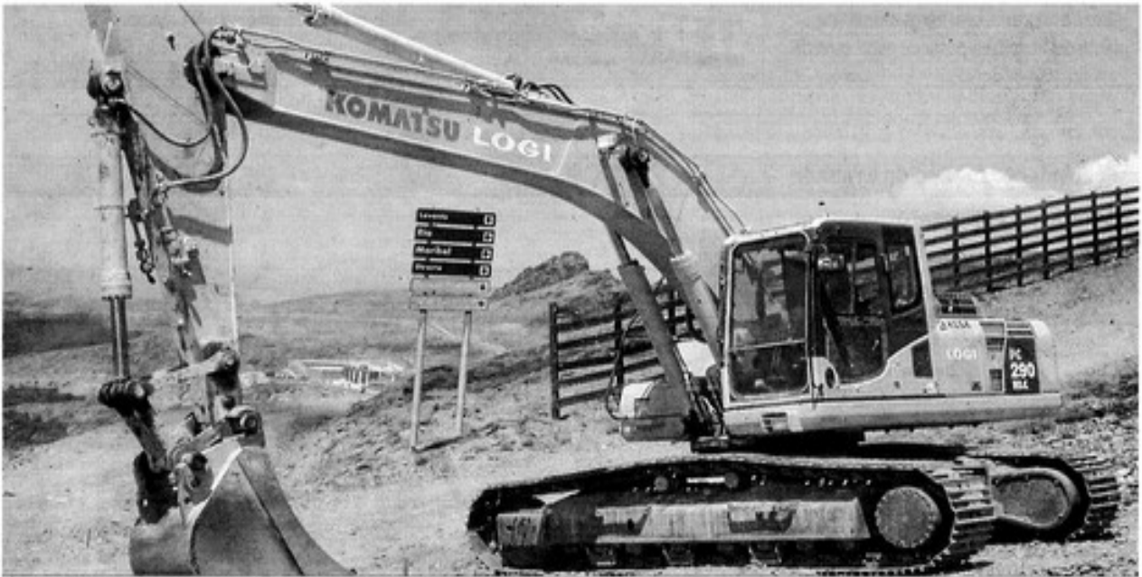
Imagen de una de las máquinas que trabaja en la creación de la pista para la Universiada en la estación de esquí.
