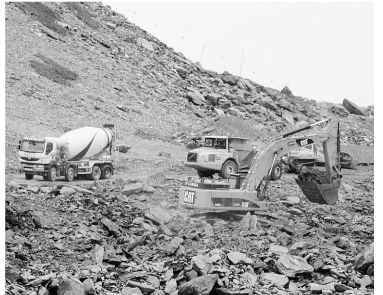
Las máquinas trabajan en la sierra. :: R. URRUTIA
